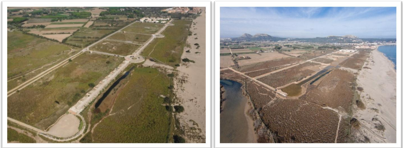
Imagen 10 y 11. La Pletera. Antes y después de la desurbanización.
