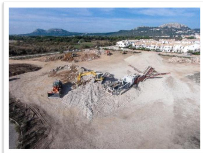
Imagen 4. Machaqueo y criba de material en zona de acopio
