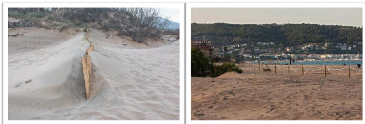
Imagen 8 y 9. Trabajos de restauración y conservación del cordón dunar
