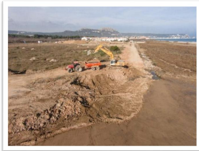
Imagen 5. Proceso de excavación de lagunas
