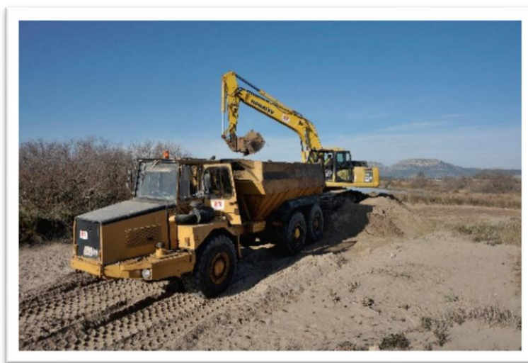
Imagen 7. Trabajos de trasvase de arenas de la marisma hacia el frente dunar
